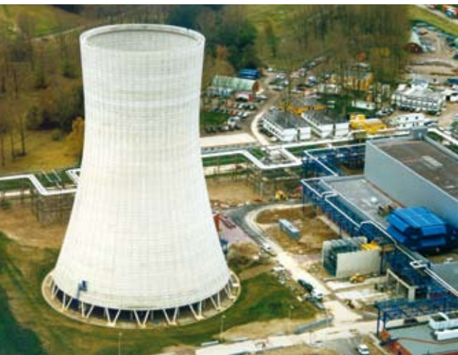
Natuurlijke trek koeltoren in Duitsland (Project van GEA Energietechnik GmbH)
