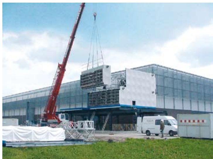
Plaatsen van een Koeltoren met een kraan op een stalen constructie
