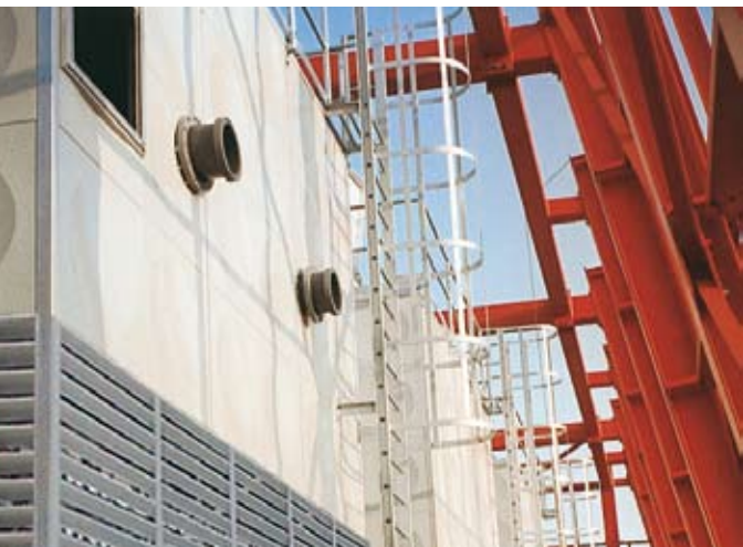
Bouw en opstarten van een CMC koeltoren
